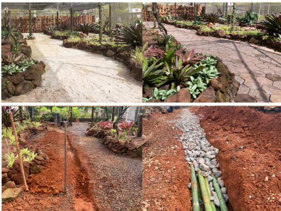
Figura 10. Calçamento e construção do dreno. Fonte: Autores, 2024.
