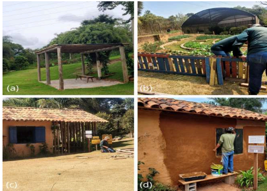
Figura 22: (a) Pergolado construído ao lado da Casinha Caipira; (b) Instalação da cerca de madeira, em torno da horta; (c) e (d) Ampliação da Casinha de Cultura Caipira. Fonte: Autores, 2024.
