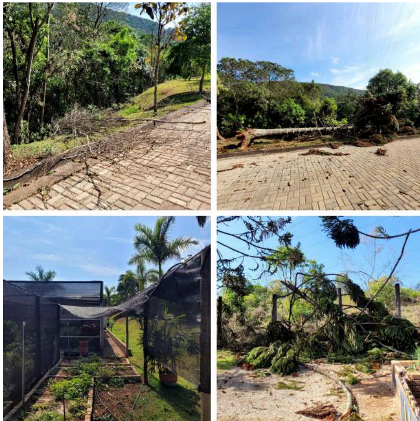
Figura 23. Áreas externas afetadas pela chuva, onde houve limpeza e reparos. Fonte: Autores, 2024.
