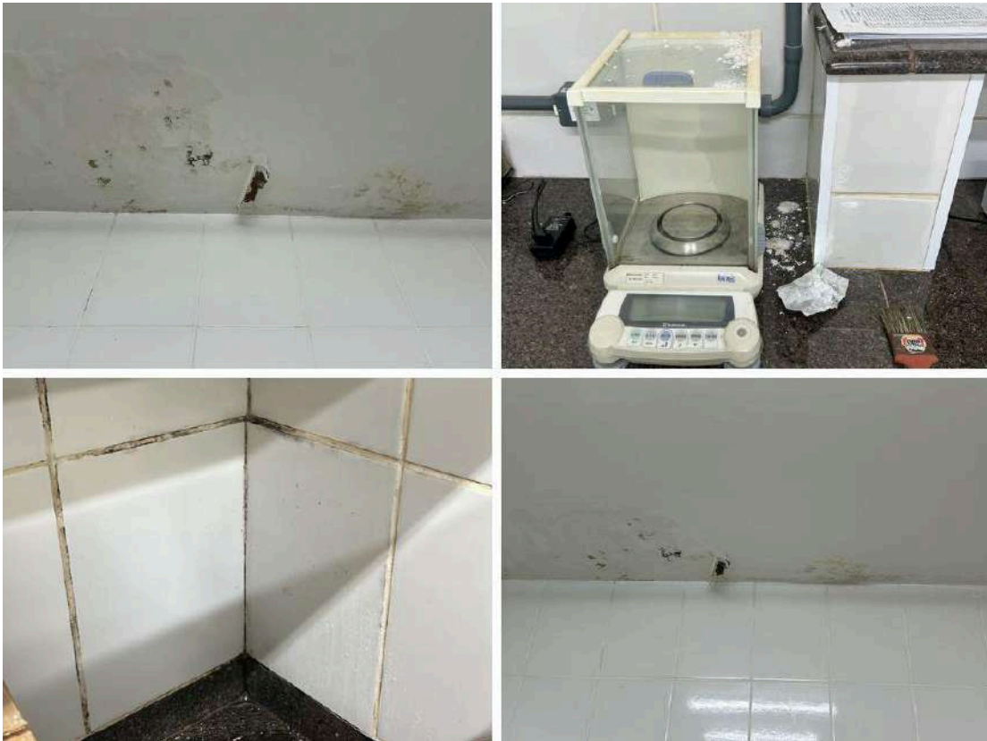
Figura 2. Novas áreas de infiltração no laboratório, mesmo após os reparos. Fonte: Autores, 2024.
