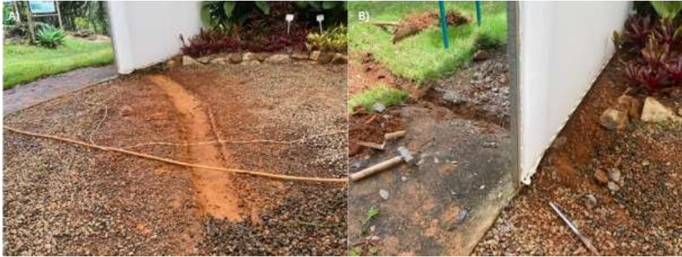
Figura 3. Construção do dreno. Fonte: Autores, 2024.
