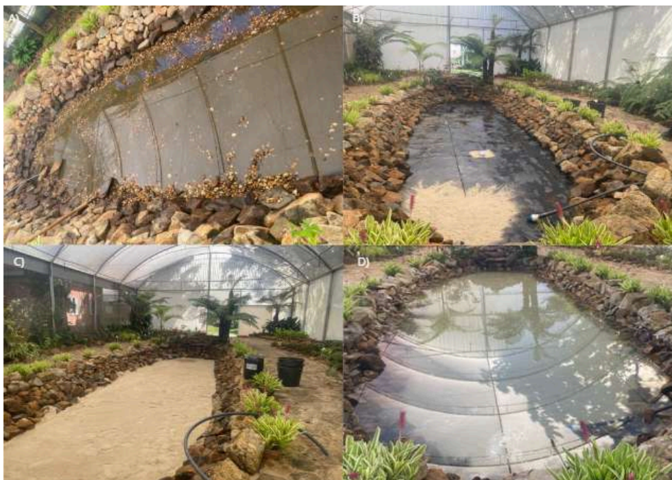
Figura 2. Substituição das pedras do lago por areia. Fonte: Autores, 2024.
