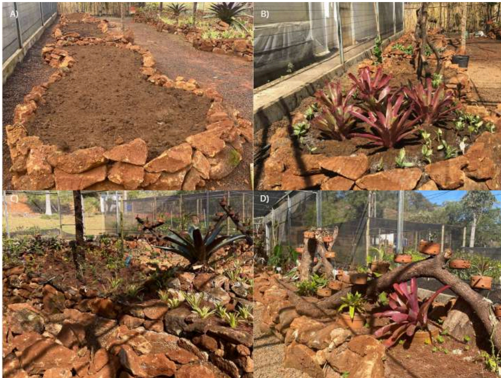
Figura 9. Construção de novos canteiros. Fonte: Autores, 2024.
