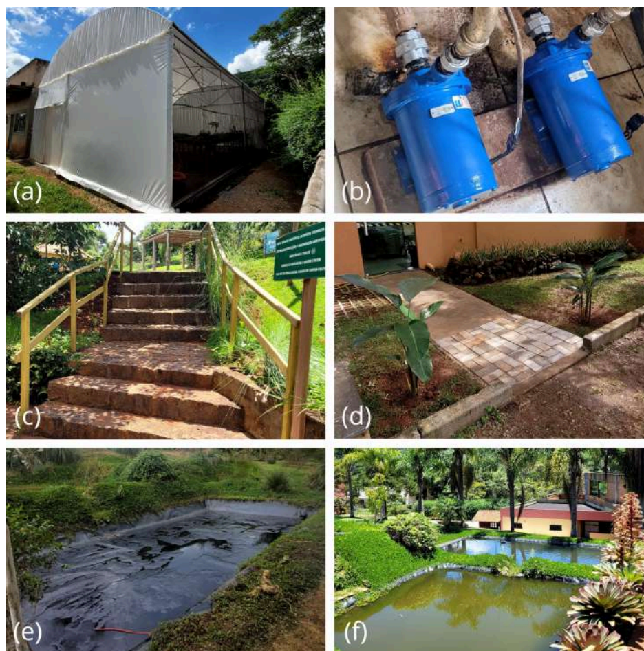
Figura 21. Instalação da nova estufa para propagação vegetal; (b) Bombas do sistema de irrigação automática, instaladas após manutenção; 9c) Instalação dos corrimãos nas escadas de acesso na área externa da Fundação; (d) Reforma do calçamento de algumas vias de acesso; (e) e (f) manutenção e limpeza dos lagos ornamentais externos da Fundação. Fonte: Autores, 2024.
